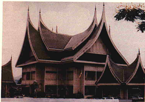
Pengaruh bumbung bentuk Minangkabau pada sebuah Pejabat Kerajaan (Dewan Undangan Negeri) di Seremban, Negeri Sembilan Darul Khusus The Minangkabau influence shown in a government building (The Dewan Undangan Negeri) in Seremban, Negeri Sembilan Darul Khusus
